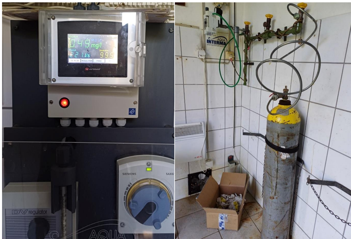
Slika 29. Automatska hlorna stanica u CS "Koraće"
