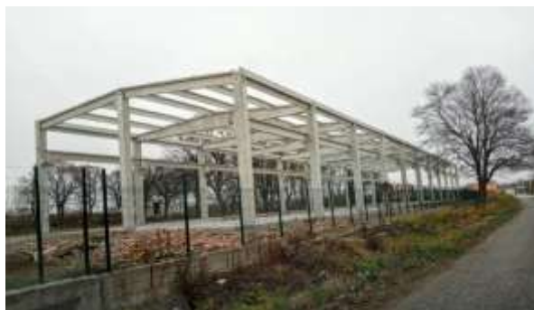
Слика 3. Градња нове производне хале „Krampitz“
