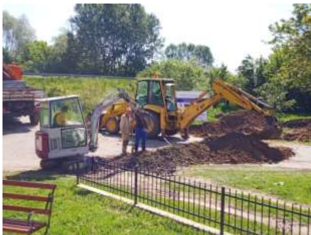
Слика 8. Нова водоводна линија на Бродском Пољу 2
