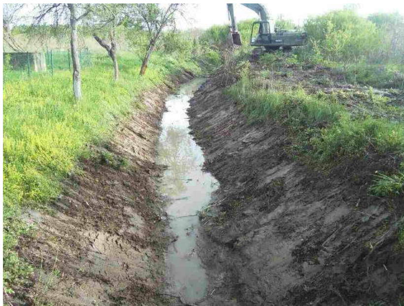
Слика 12. Чишћење канаске мреже у Бродском Пољу 2
